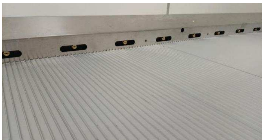
DETTAGLIO PAVIMENTO CON FINITURA ANTISDRUCCIOLO
